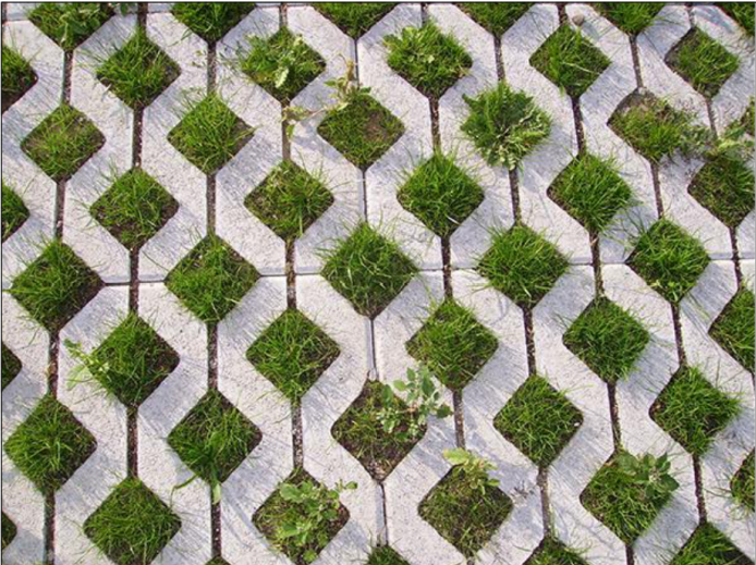
Pavimentazione in prefabbricati in cls, riempiti di substrato e ineriti posati su apposita stratificazione di supporto
